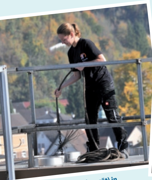
die Kugel (Ableingerät) in das Kamin einführen
