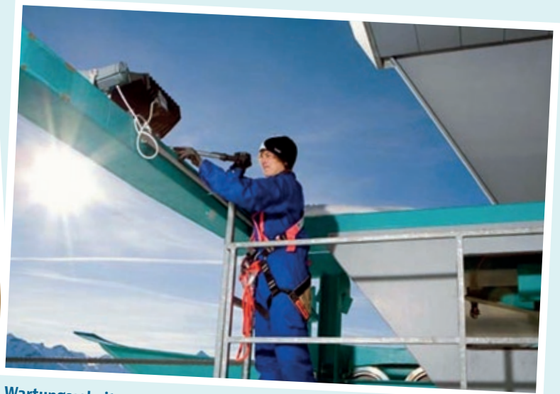
Wartungsarbeiten an der Bergstation
