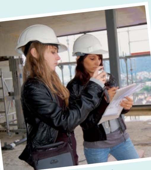
Pläne mit der Situation auf der Baustelle abgleichen
