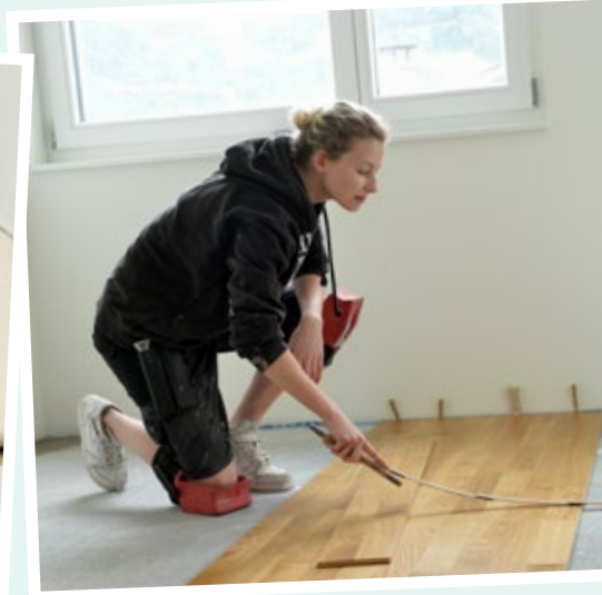
exaktes Einmessen des Bodenbelages
