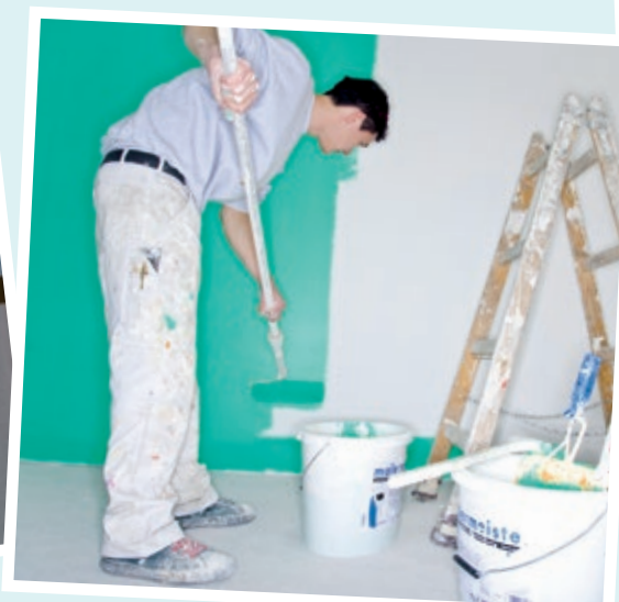
Wandfarbe mit der Rolle aufbringen
