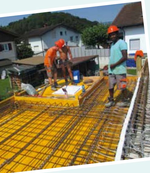
Baustahlgitter auslegen
