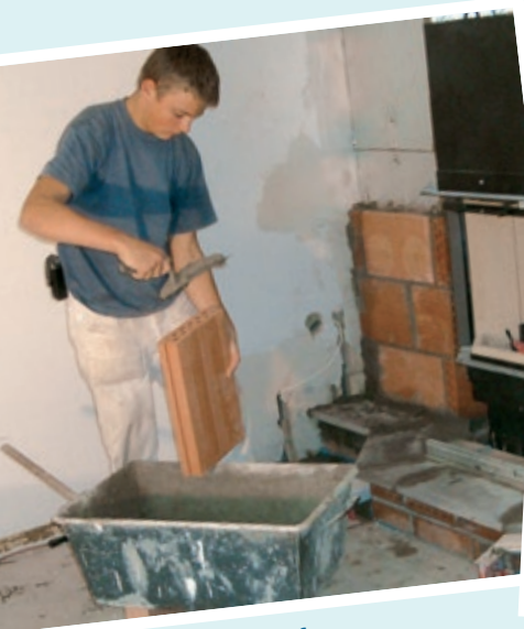
Einbau eines Ofens
