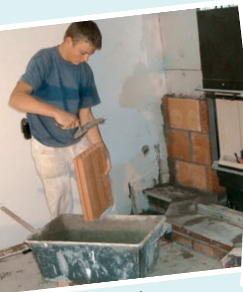
Einbau eines Ofens
