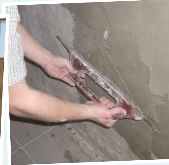
Grundierung auftragen
