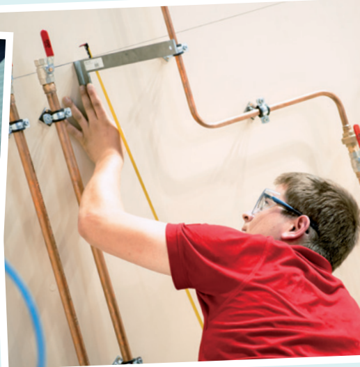
Verlegung der Heizungsrohre
