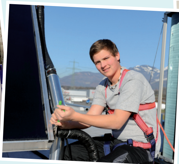
Montage eines Solarkollektors
