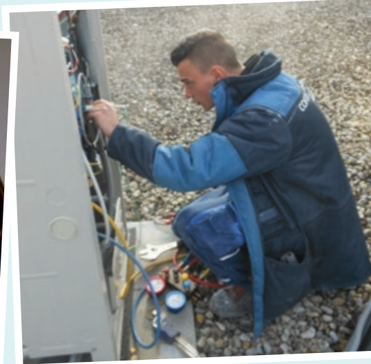
Überprüfung der Klimaanlage
