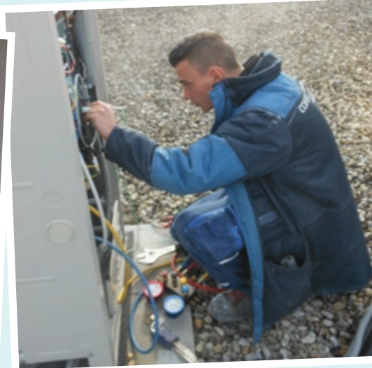
Überprüfung der Klimaanlage
