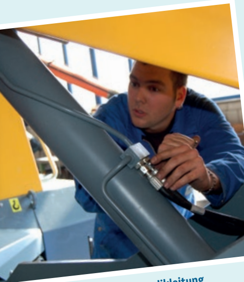
Montieren einer Hydraulikleitung
