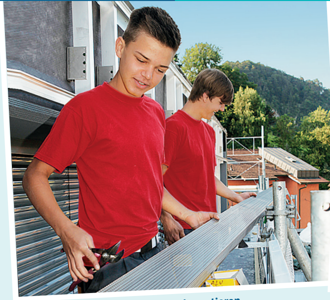
Fassadenelemente bearbeiten und montieren
