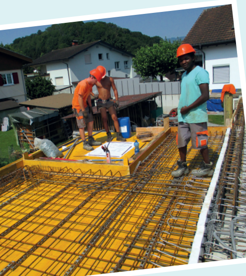
Baustahlgitter auslegen
