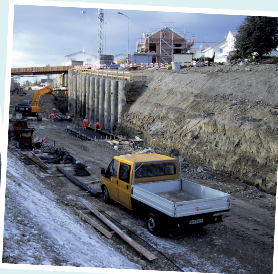
Bau einer neuen Straße
